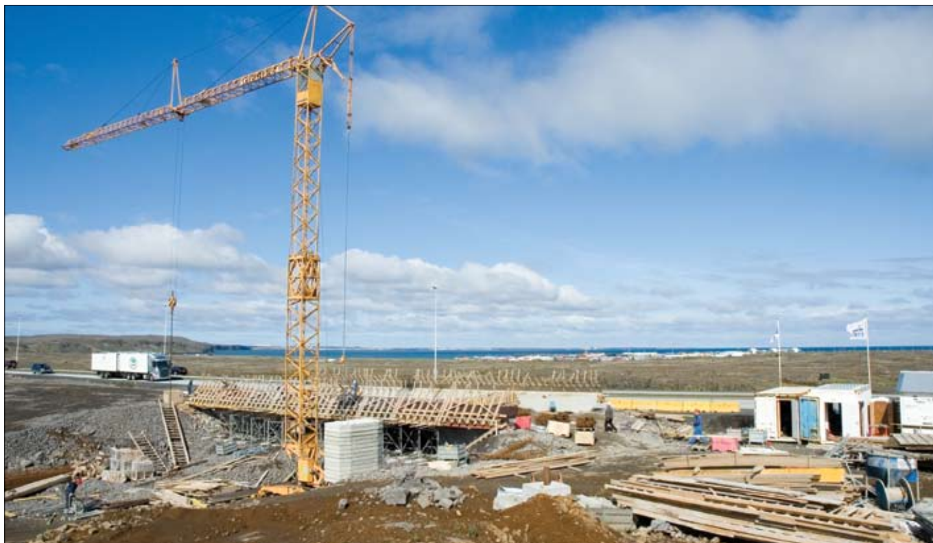
Reykjanesbraut. Mislæg gatnamót í byggingu við Voga.
